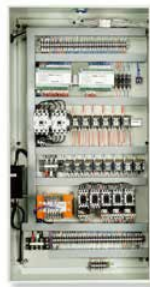
電控箱裝置 Electrical Cabinet
