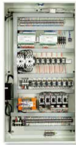
電控箱裝置 Electrical Cabinet
